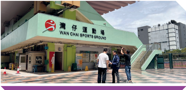
通訊辦職員在政府場地檢查已安裝的無線電基站。
