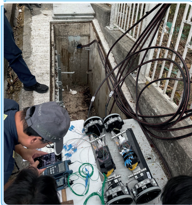
通訊辦職員就擴展光纖網絡至偏遠地區鄉村資助計劃下安裝的光纖電纜進行驗收工作。
